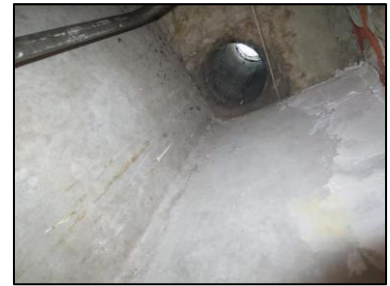
Photo N° 704 AMIANTE CIMENT 1 LORIENT--PLACARDS GAZ +8 Plafonds Ventilation haute (Fibres- ciment)
