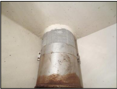
Photo N° 685 AMIANTE CIMENT 1 LORIENT-RDC-V.O Vide-ordures Gaine V.O.(Fibres-ciment)
