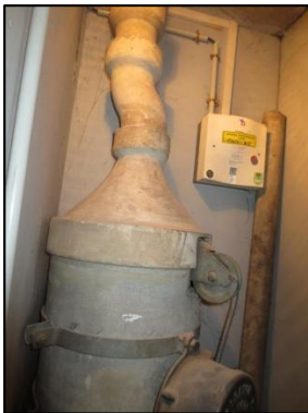
Photo N° 799 AMIANTE CIMENT 1 LORIENT-1er-LOCAL V.O +1 à +8 Vide-ordures Gaine V.O.(Fibres- ciment)
